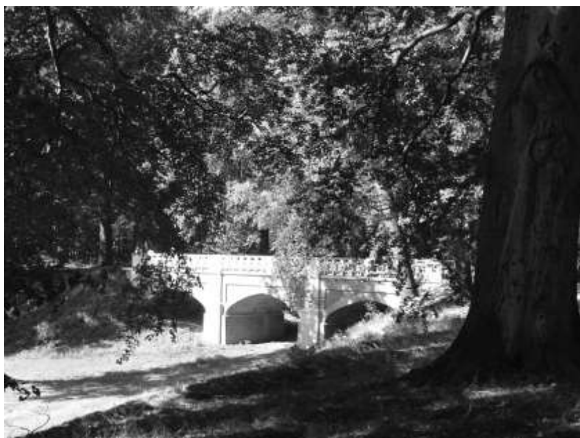
Ryc. 84. Mużaków, most królewski po zakończeniu prac konserwacyjnych – zdjęcie Anna Róžańska.
